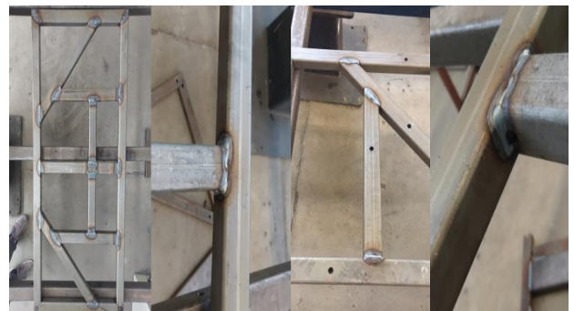
图 13 客车踏板焊缝实际效果
